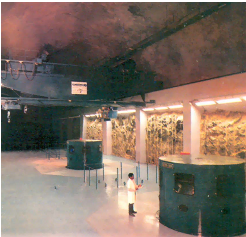
Iz hidroelektrane Kidatu u Tanzaniji
